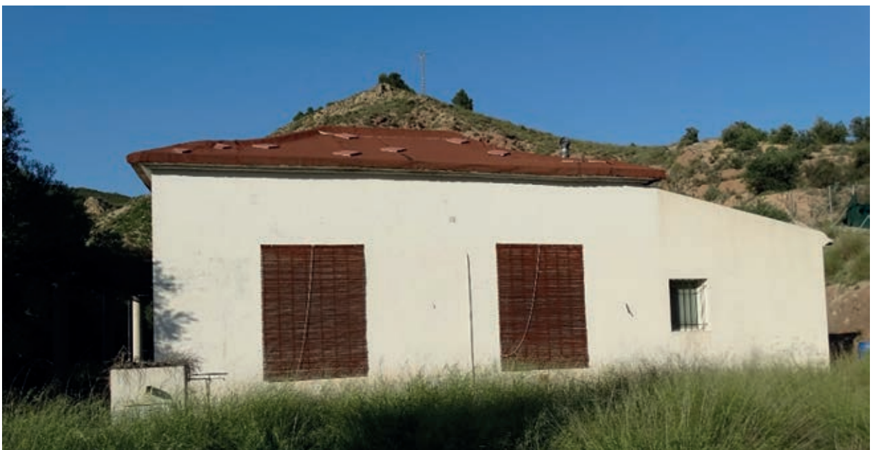
Fotografía del edificio de 1955 en la actualidad. Foto de la autora
