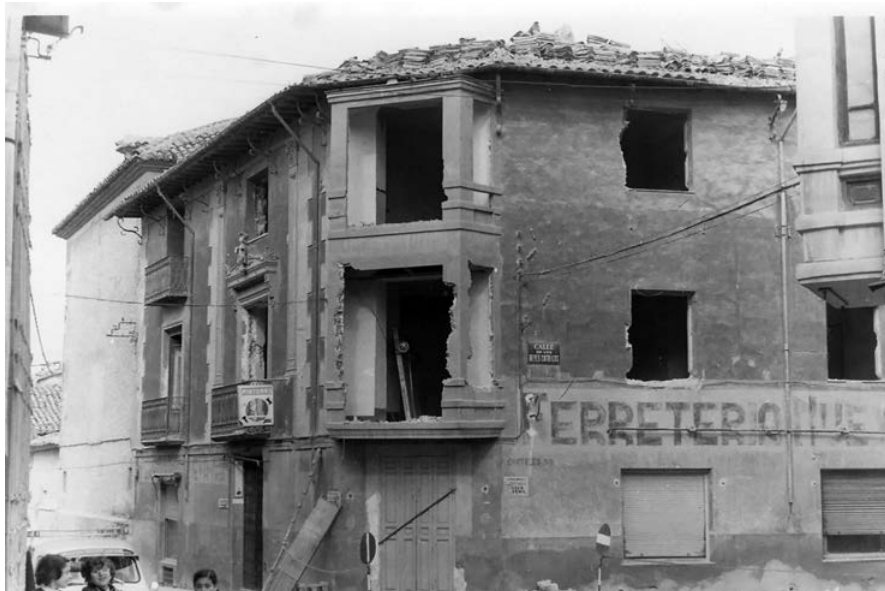
La casa de los Quilez en los momentos previos a su demolición (1975). Se puede observar el escudo que campeaba sobre el primer el balcón.
