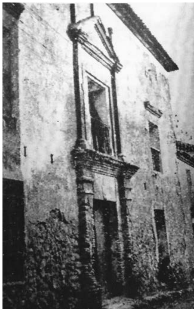
Casa Roldán. Estado previo a su demolición
